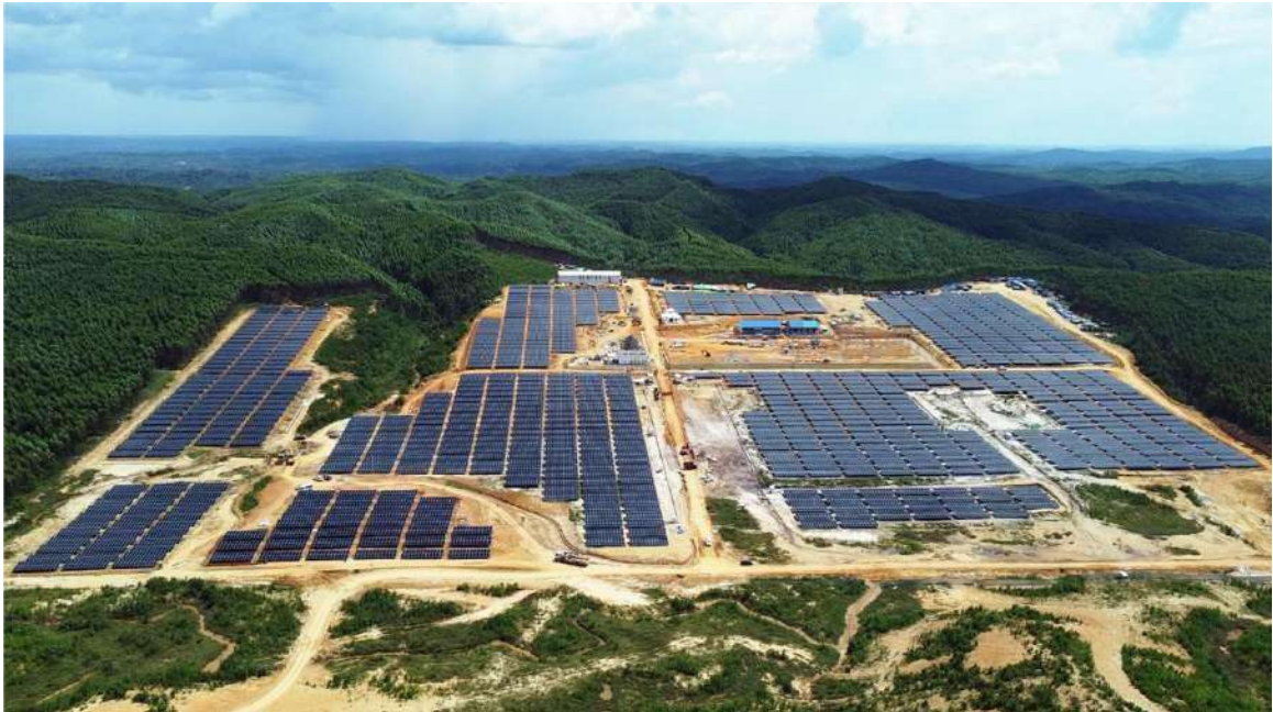
Gambar 56. Pembangkit Listrik Tenaga Surya (PLTS) Ibu Kota Negara (IKN) Nusantara
